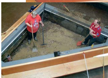
Sanierung der Pflanzkästen im Lichthof der Werkstatt Fechenheim. Oben ein Blick auf die Neubepflanzung.
