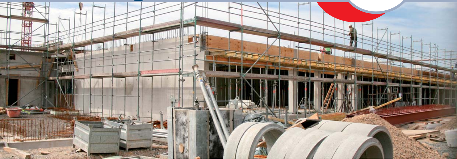
Die neue Werkstatt nimmt Gestalt an: Im Bild zu sehen sind die Gruppenräume für die Konfektionierung; geschalt wird gerade der Bereich der Scan-Abteilung im Obergeschoss.
